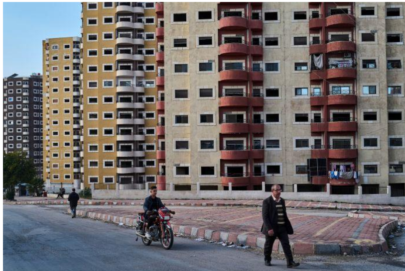
Housing Blocks, 2025, Dominic Nahr © Dominic Nahr (BITTE BEACHTEN Sie die Nutzungsbedingungen des Bildmaterials am Ende des Dokuments)
